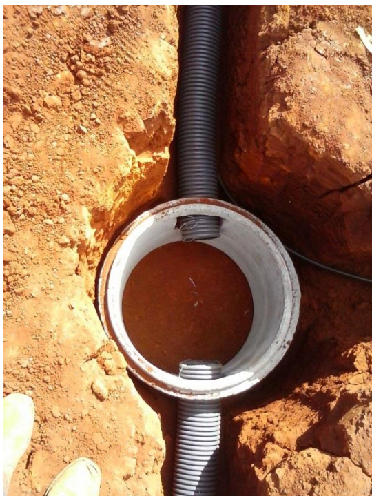
Detalhes das caixas de passagens
